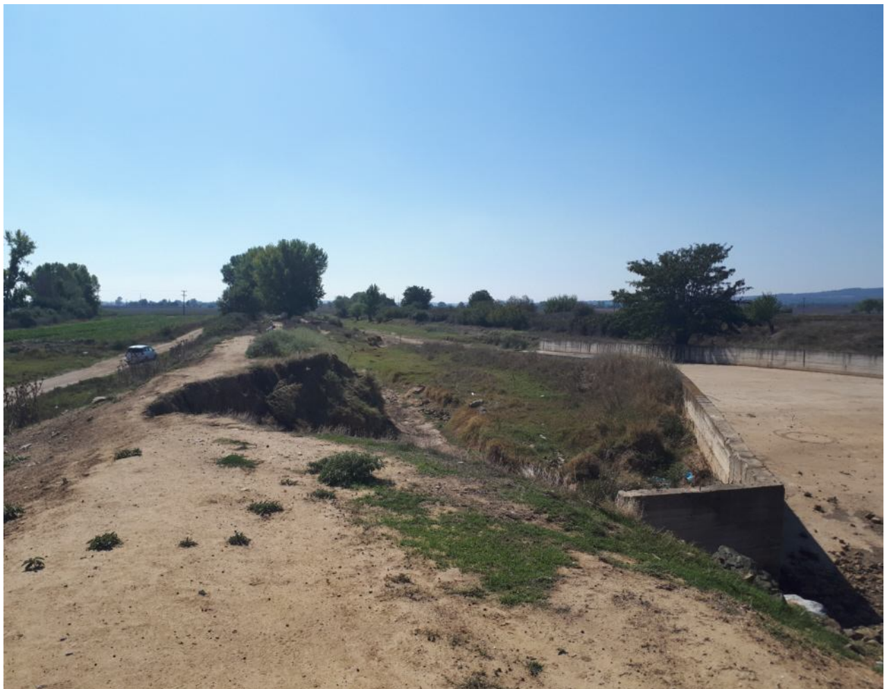
ΦΩΤΟΓΡΑΦΙΑ 6: Φθορά αναχώματος
