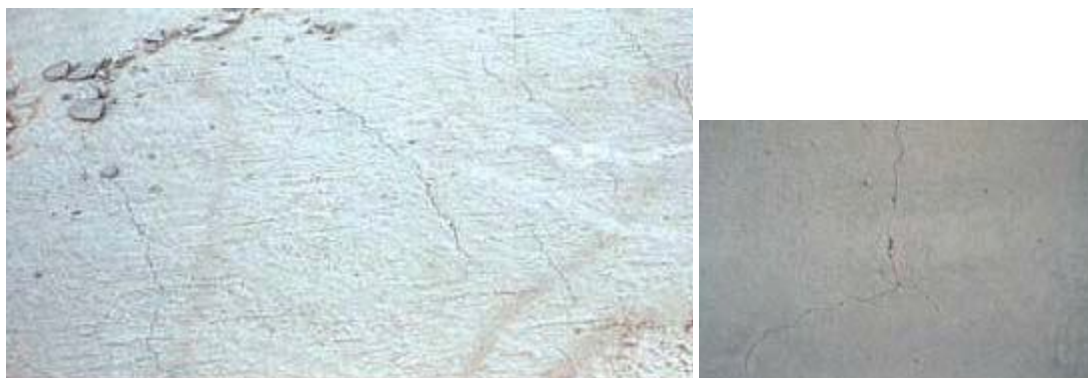
Εικόνα 1 - Ρηγμάτωση σκυροδέματος σε πλαστική κατάσταση
