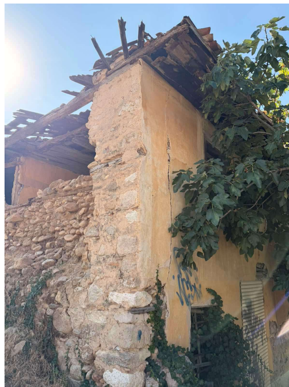
Φωτ. 5 ΒΔ Γωνία
