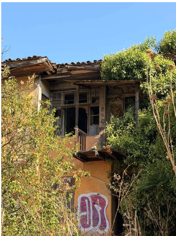
Φωτ.4 Νότια όψη- Χαγιάτι
