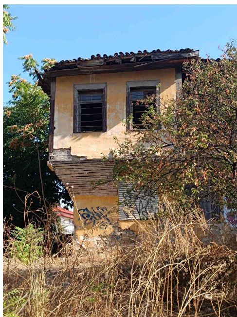
Φωτ. 6 Νότια όψη – Σαχνισί
